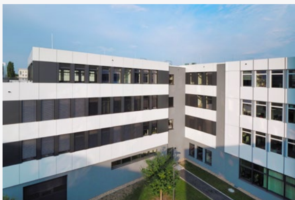
Links der Anbau, rechts der Bestand (Blick vom Innenhof)
