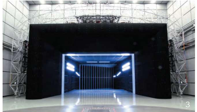
Bild 3: Arrays und Traverse in Parkposition [1]
